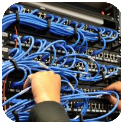
Red para sistema de cámaras
